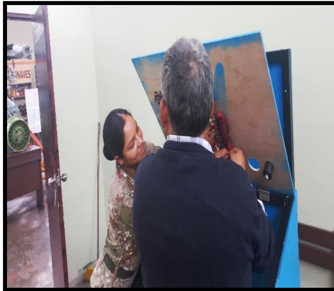
Figura19. Protección del cableado eléctrico
