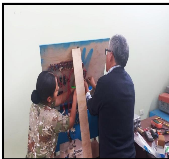
Figura18. Armado del cableado en el panel central
