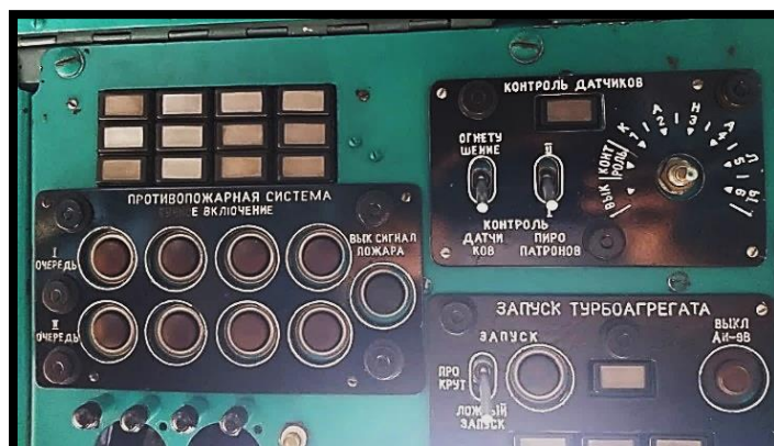
Figura 4. Luces de Señalización
