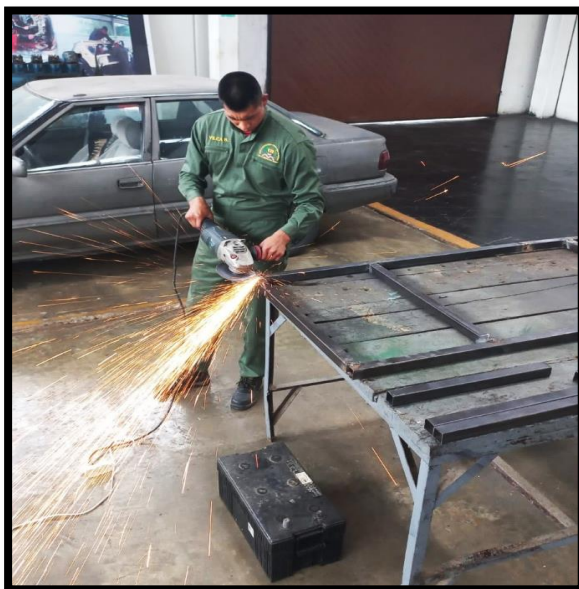
Figura 9. Elaboración de la estructura de hierro.
