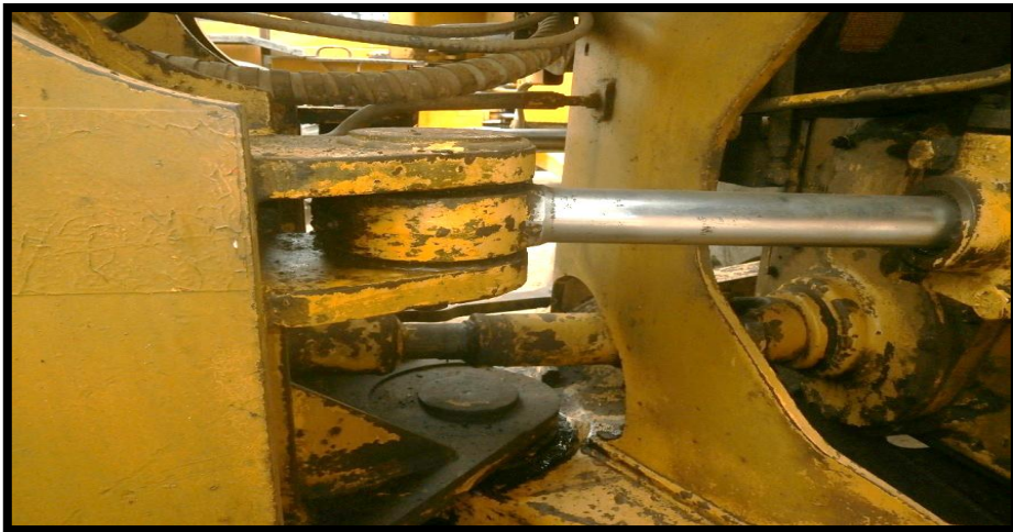
Figura 25: Cilindros hidráulicos de dirección sin lubricación y oxido.
