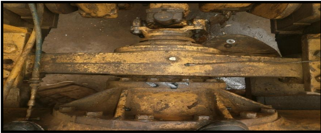
Figura 31: Puente con las cañerías rotas con partículas contaminantes en su interior.
