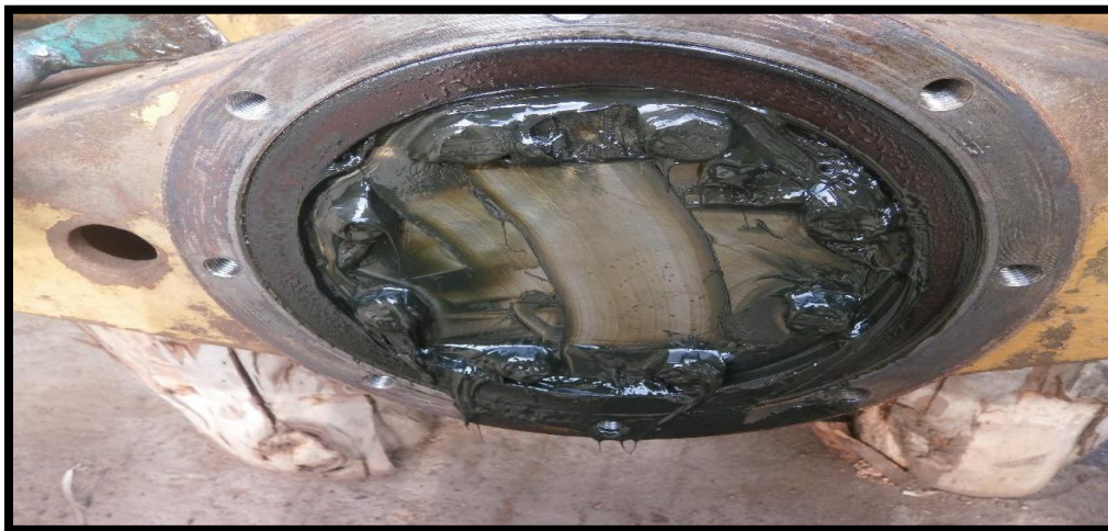
Figura 32: Grasa vencida en el puente de suspensión basculante.
