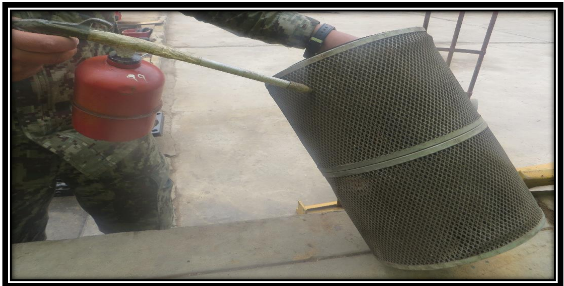
Figura 31: Mantenimiento correctivo al filtro de aire
