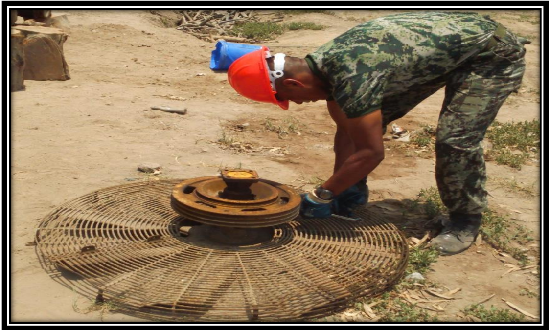
figura43: Mantenimiento y reparación del ventilador
