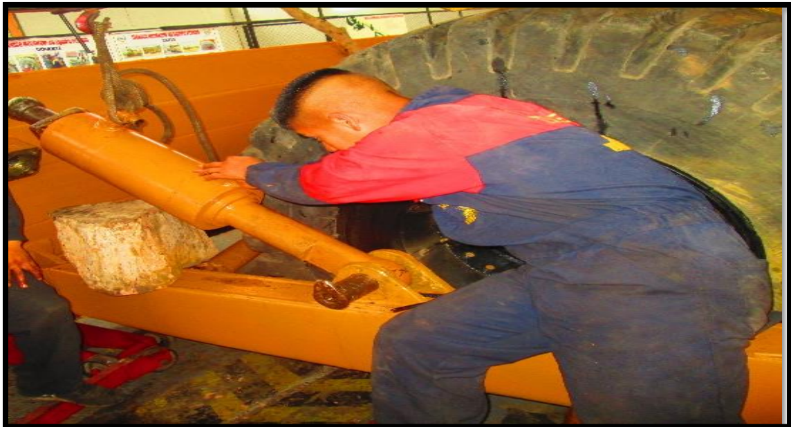
Figura 38. Colocación de cilindros y pines después del mantenimiento respectivo.
