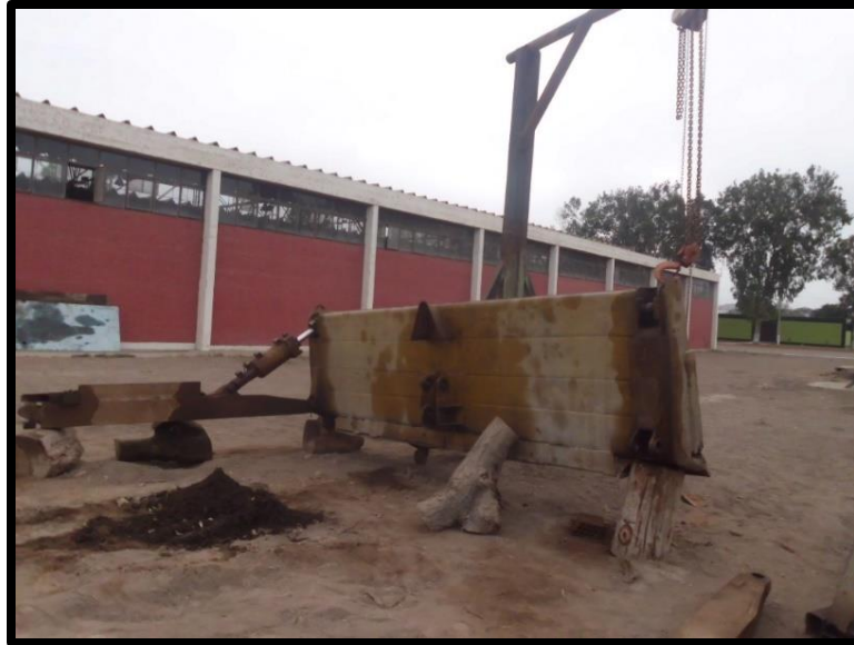
Figura 29. Lampón: estructura del lampón con desgaste corrosivo, soportes de los pines del bastidor debilitados por excesivo desgaste.
