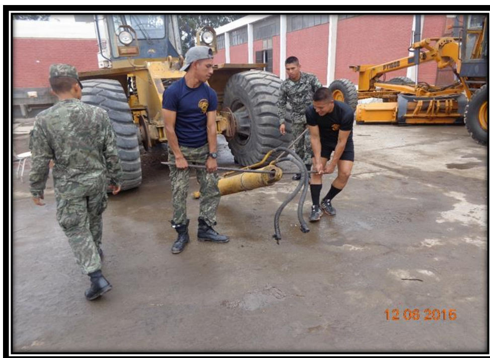
Figura 32: Mantenimiento del cilindro hidráulico del ampón
