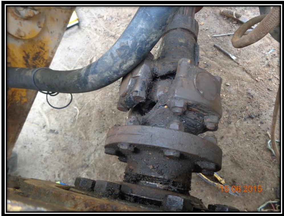
Figura 27: Eje cardan en mal estado
