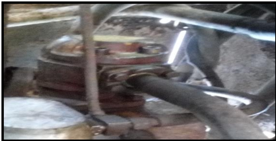
FIGURA 21. LA VÁLVULA DE CHECK ENCARGADO DE CONTROLAR LA PRESIÓN O LA DIRECCIÓN DEL FLUJO.
