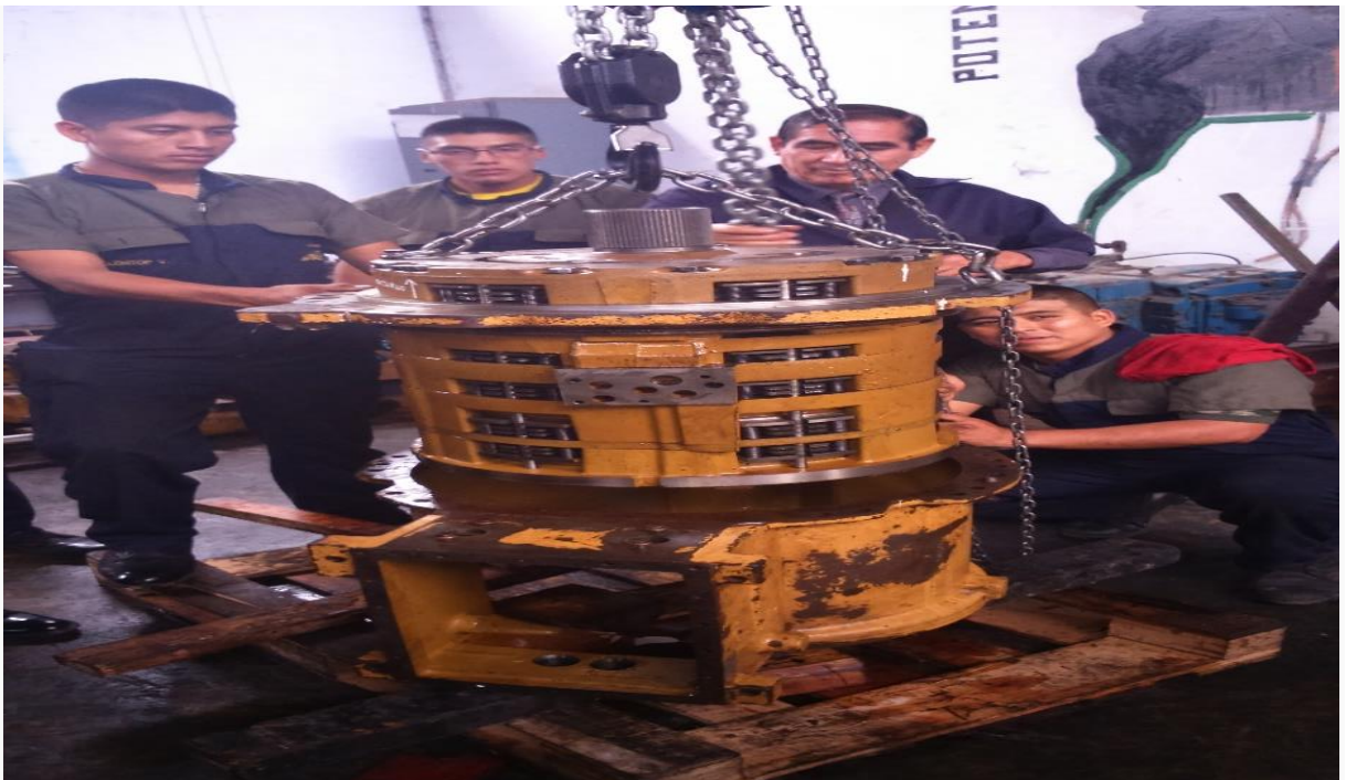
Figura 05 desmontajes de la caja de transferencia
