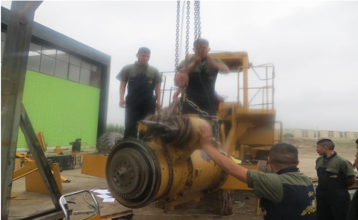
Figura 29 Montaje de la caja de transferencia
