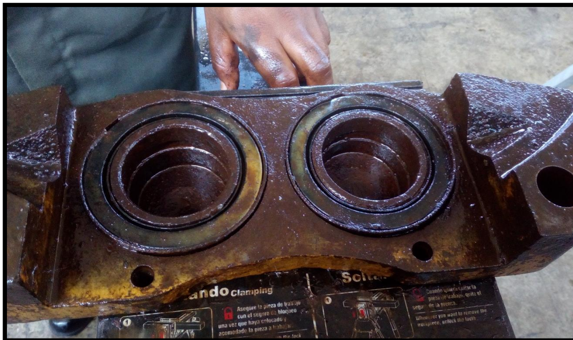
Figura 24 Estructura de cilindros con ataque corrosivo.
