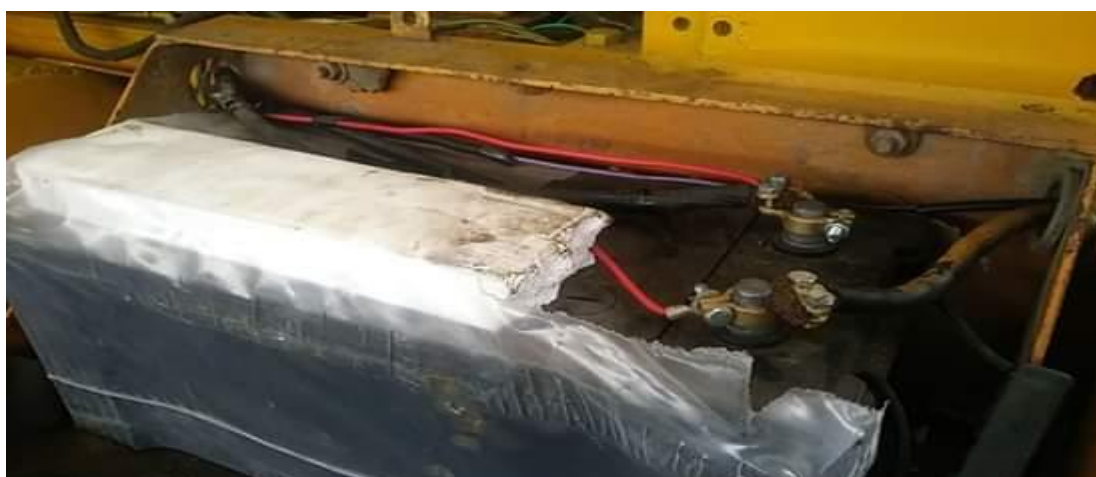
Figura 17: Batería nueva instalada en cada lado en del tractor a ruedas TL210A
