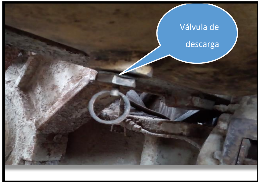
Figura 27. Válvula de descarga de agua
