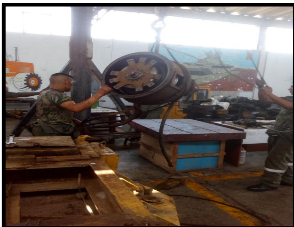
Fotografía 2. Desmontajes del Sistema de Transmisión
