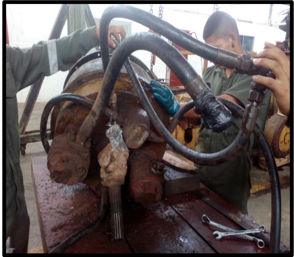
Fotografía 3. Mantenimiento correctivo de del convertidor de par
