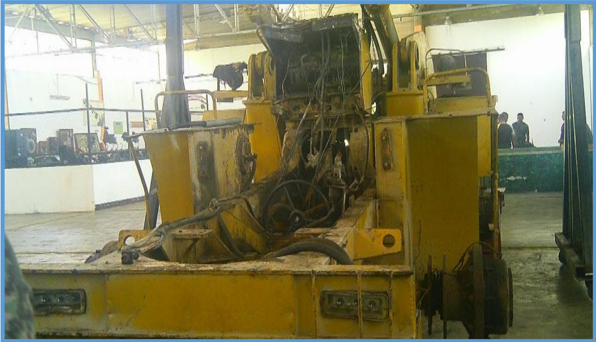
Fotografía 5. Revisión del estado de los cables que se encuentran en el Tractor a Rueda
