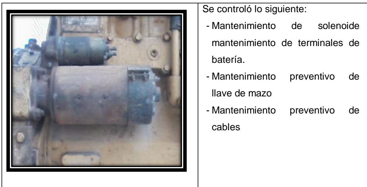
Fotografía 13: Mantenimiento del sistema eléctrico
